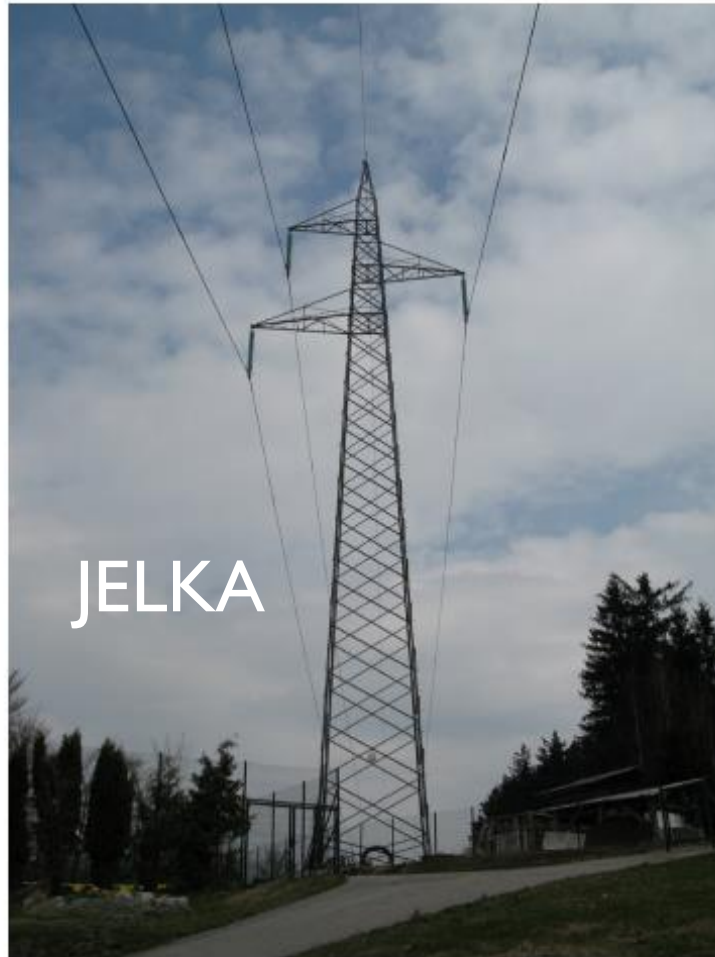
S2: Najpogostejša tipa stebrov enosistemskega VN daljnovoda. Levo jelka, desno ipsilon.
