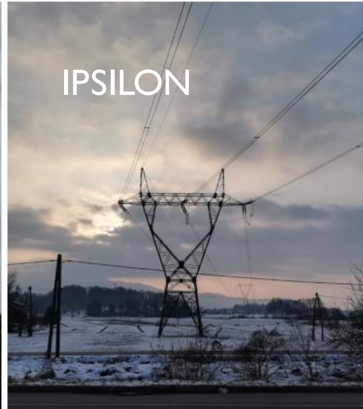
S2: Najpogostejša tipa stebrov enosistemskega VN daljnovoda. Levo jelka, desno ipsilon.
